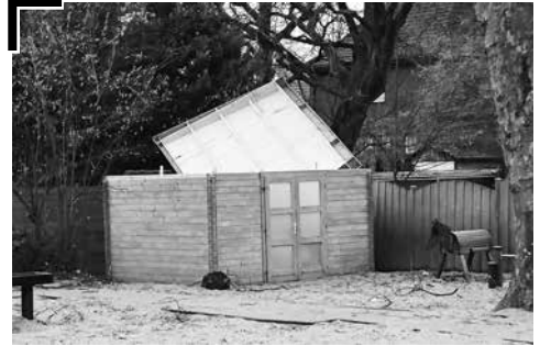
Im Januar fegte Sturmtief Frederike über unsere Kirchengemeinde hinweg. Auch an unseren Kirchen und Pfarrheimen gibt es zahlreiche Schäden. An der Kita St. Ida wird das Spielhaus abgedeckt.
